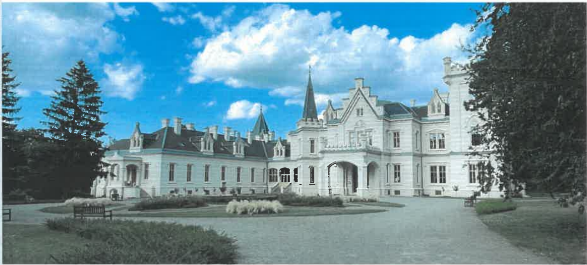
A kastélyfőhomlokzata 2023 júliusban
